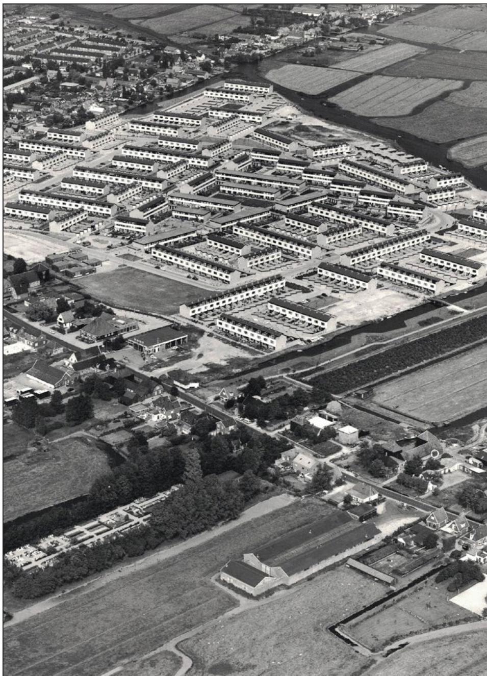
Havenzathe tijdens de aanleg van de wijk in 1970
